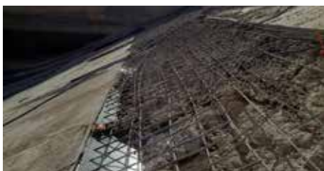
Ready to pour new concrete.
