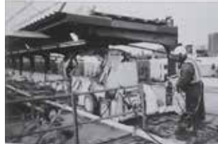
Det gäller att hålla tungan rätt i mun och ha koll på rivningsroboten på den smala tunnelbanebroen.
